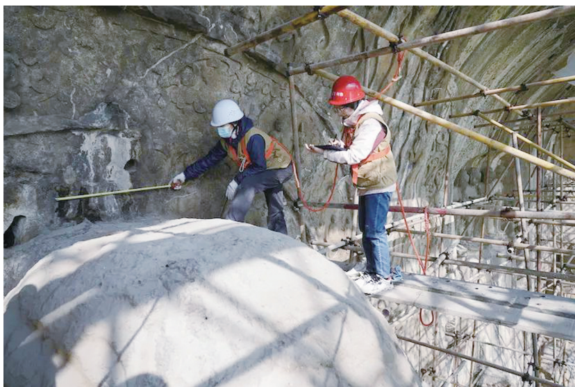
河南洛阳龙门石窟工作人员正在对卢舍那大佛进行病害调查
