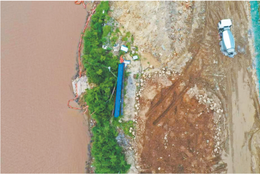
平陆古渡码头迁移前航拍
