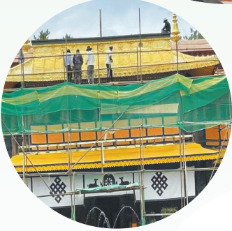
布达拉宫二期保护维修屋面阿嘎土施工现场
