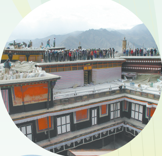
布达拉宫二期保护维修屋面阿嘎土施工现场
