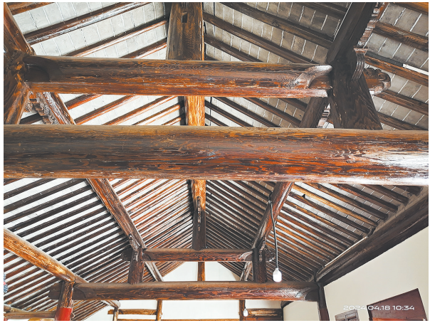
明代建筑玉皇殿的屋顶桁樑
