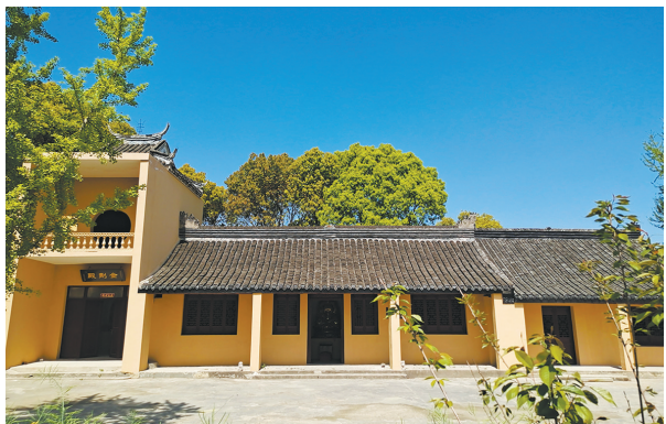
明清建筑——玉皇殿（右）、金刚殿（左）
