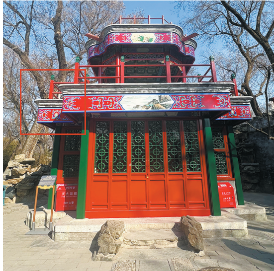
工程完成后妙香亭一层角柱口
